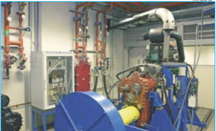
Infrastructure d'essai pour le test Ampère.
